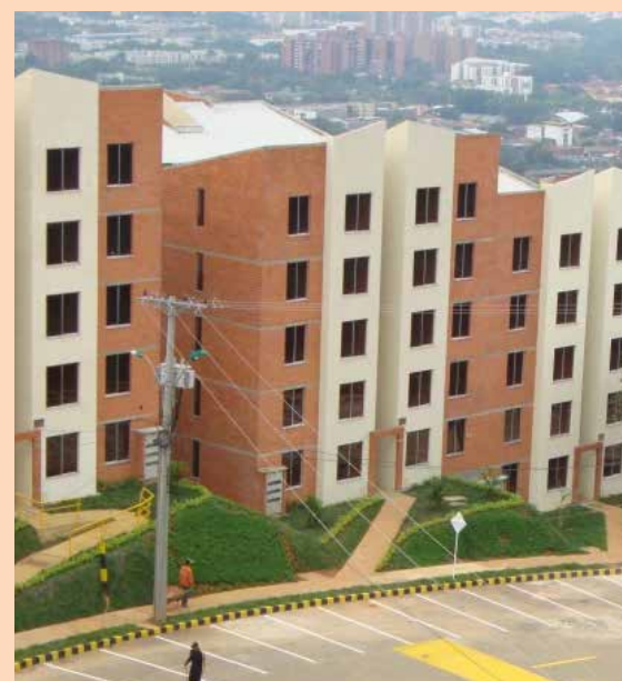
➤ Viviendas de interés prioritario.
